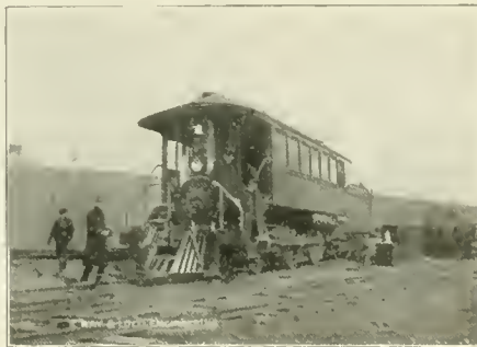
INSPECTION ENGINE, C. R. R. OF N. J.
